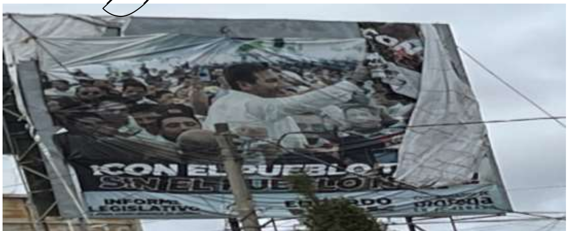
(...) Imagen 8.1 Fotografías tomadas sobre el Boulevard de las Federaciones y/o Carretera Internacional Comitán San Cristóbal de las Casas, kilómetro 170, arco de la entrada a la ciudad de Comitán en el municipio de Comitán; Chiapas, las cuales dan cuenta del lugar y del anuncio tipo espectacular localizado. Nota: Las demás imágenes se encuentran insertas en la resolución
